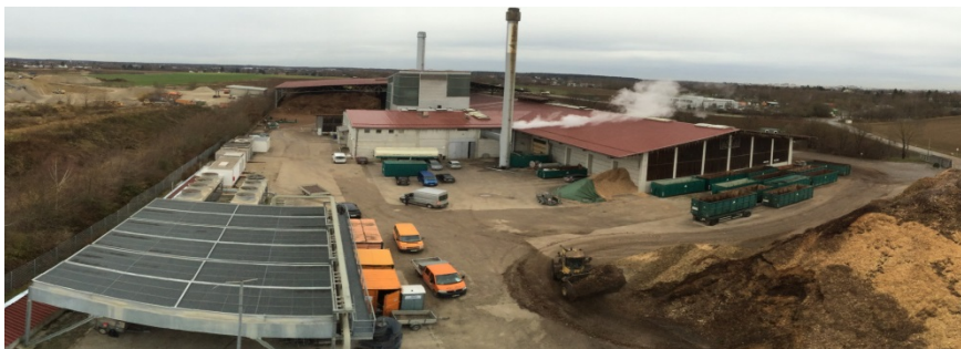
BioEnergie Taufkirchen: Panoramaansicht der Anlage.
